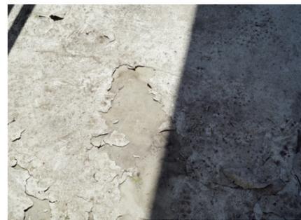
feine Risse bekommen, kommt es bei anhaltender Staunässe zur Durchfeuchtung der darunterliegenden Balkonplatte. Der gleiche Effekt tritt auf, wenn die Seitenränder der Abdichtung bei starkem Regen und schlechter Entwässerung länger "unter Wasser" stehen. Die Folge: das in die Bodenplatte eingedrungene Wasser verdampft bei ausreichender Erwärmung z. B. durch Sonneneinstrahlung wieder. Die an sich gasdichte Epoxidharzbeschichtung wird nun in die Höhe
